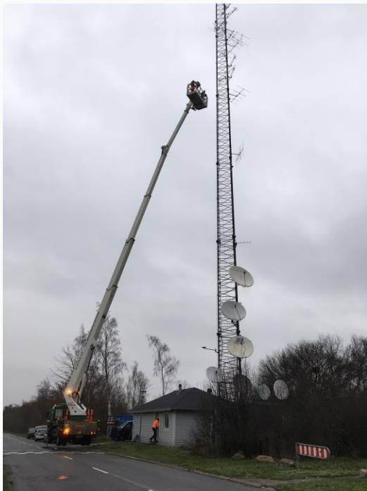
Opsætning af antenner og parabol i Hårlev
